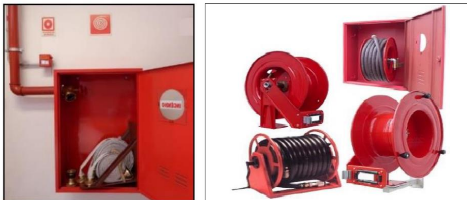
Figura 8: Exemplo de Sistema de Hidrante e Mangotinhos
